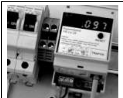
Bild 2.1.1 VR-14 utrustningen kan monteras på DIN 35 skena.
